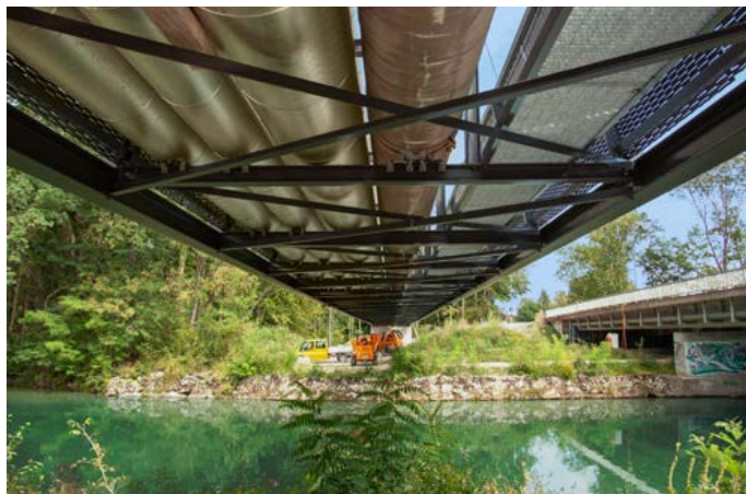
BSB + Partner ermöglichte eine sichere Überführung der Werkleitungen über die Emme.
