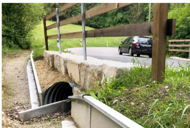
Mittels Tunnelsystemen queren die Amphibien und andere Tiere die Strasse sicher.
