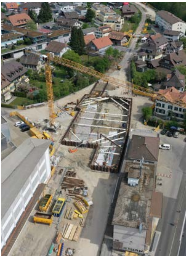
Beim Bahnhof Neuenegg entsteht eine moderne Anlage mit zwei Aussenperrons.
