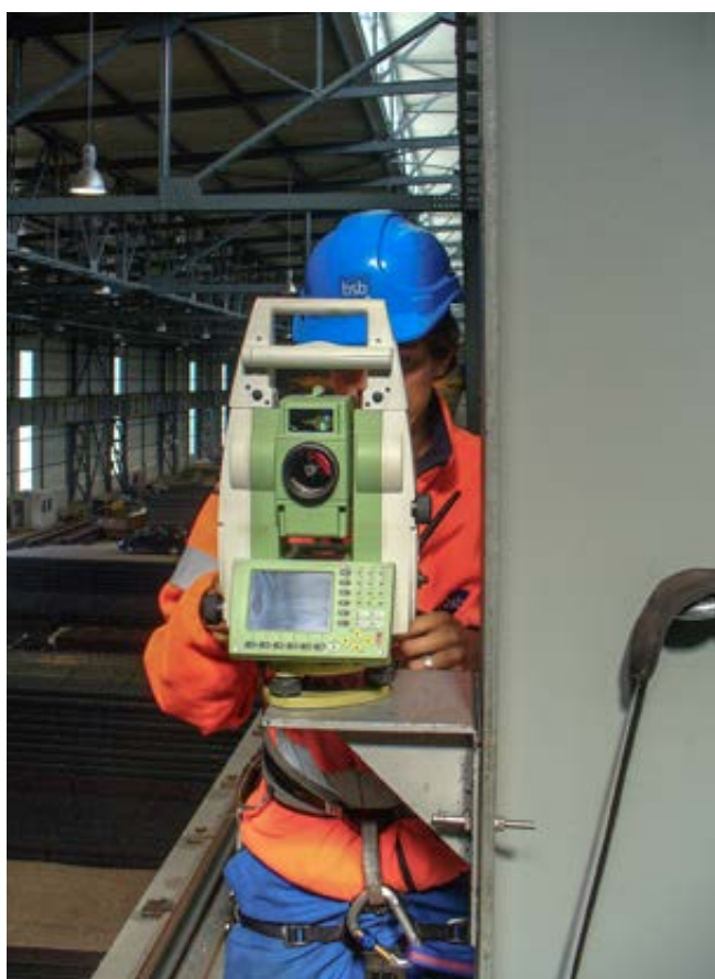
Die vermessungstechnische Kontrolle sichert den Betrieb der Kranbahnen.
