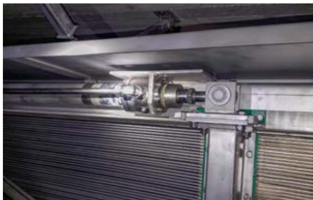
Eingebauter Siebrechen
