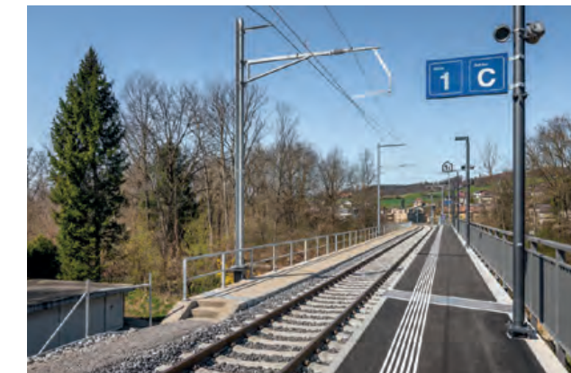
Sensebrücke beim Bahnhof Flamatt Dorf
