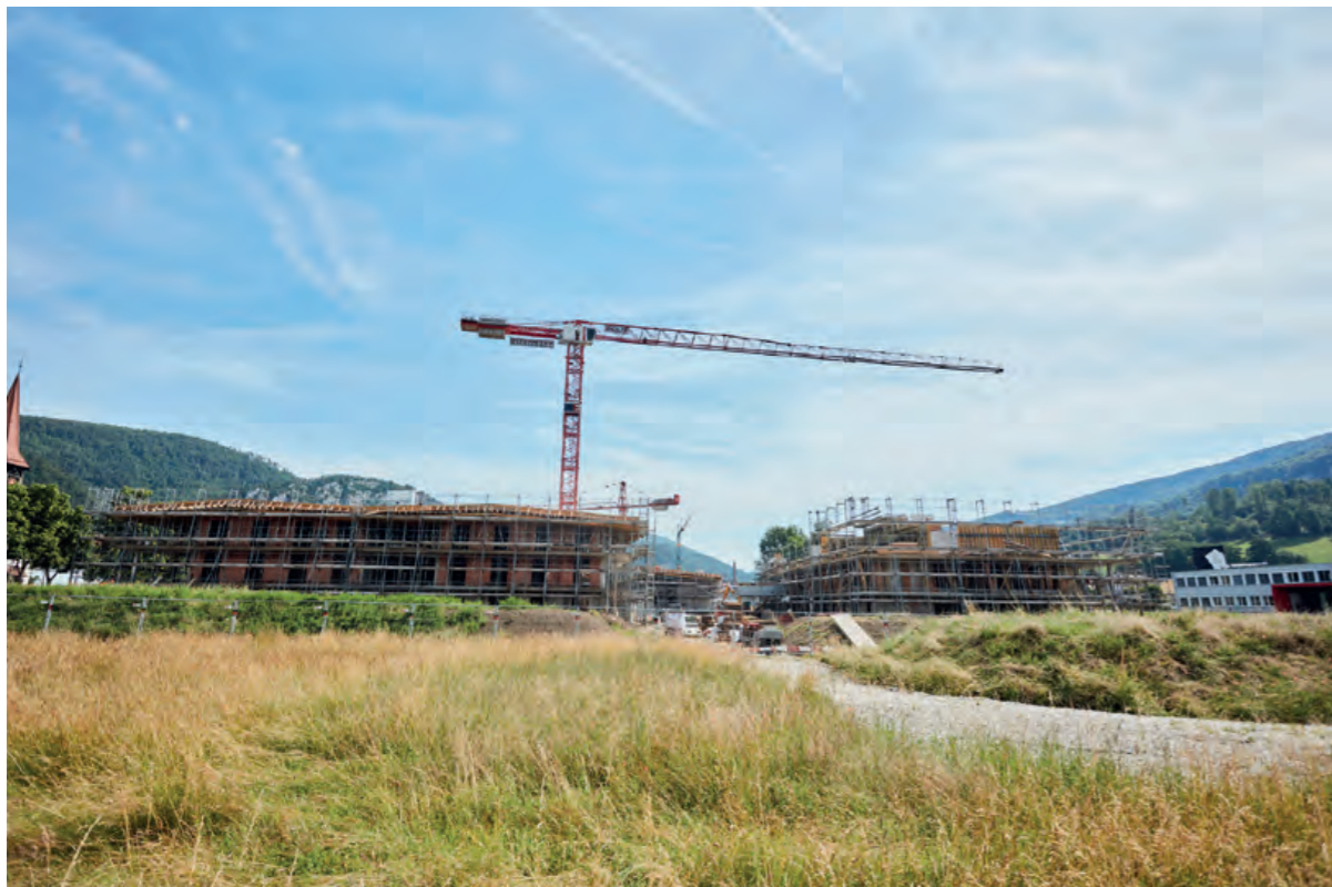
Rohbau der Gruppengebäude A + B
