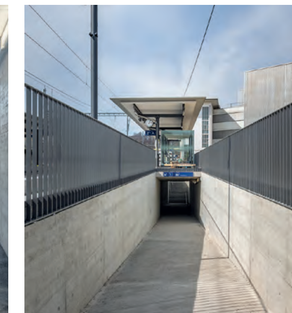
Fussgängerrampe Bahnhof Neuenegg
