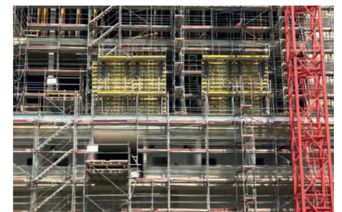
Schalungen und Gerüst
