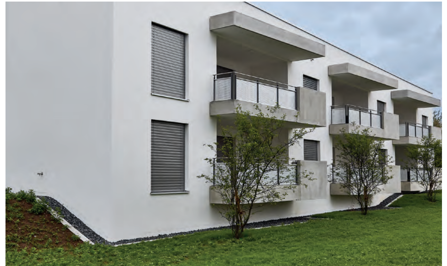
Neubau Mehrfamilienhaus Hohlenstrasse – Ivo Erard Architekten + Planer AG
