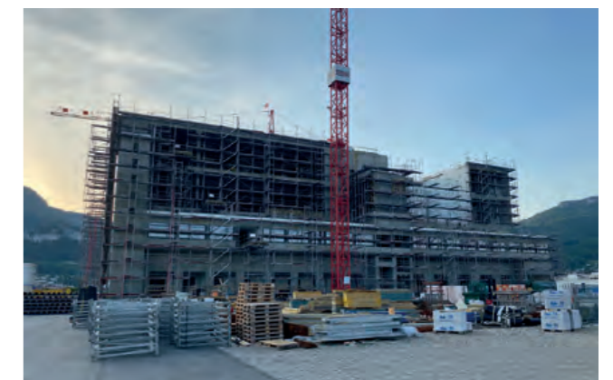
Tiefkühlager im Rohbau
