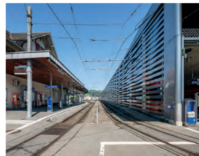
Zu überprüfende Situation bei bestehenden Haltestellen
