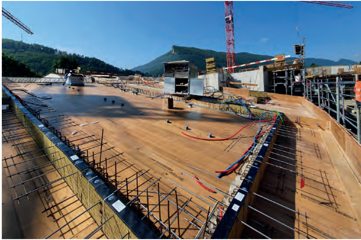
Deckenschalung Mehrzweckgebäude mit Kragplattenanschlüssen
