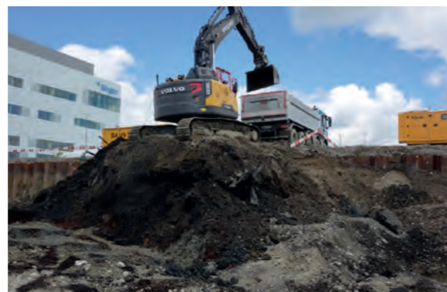
Auflad für den Transport in die Zwischendeponie
