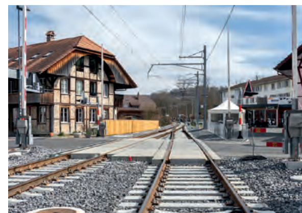
Neuer Bahnübergang und neue Weichenanlage
