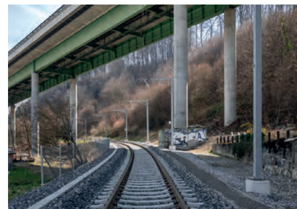
Neues Bahntrasse unter dem Autobahnviadukt in Flamatt
