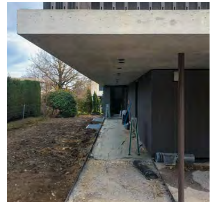
«Aufhängung» der Auskragung über dem Eingang mit Wandscheiben im Obergeschoss
