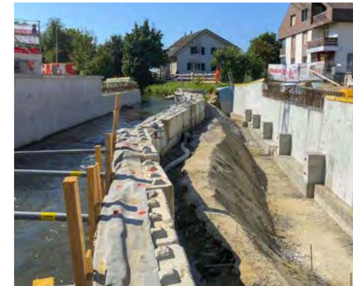
Baugrube mit Wasserhaltung
