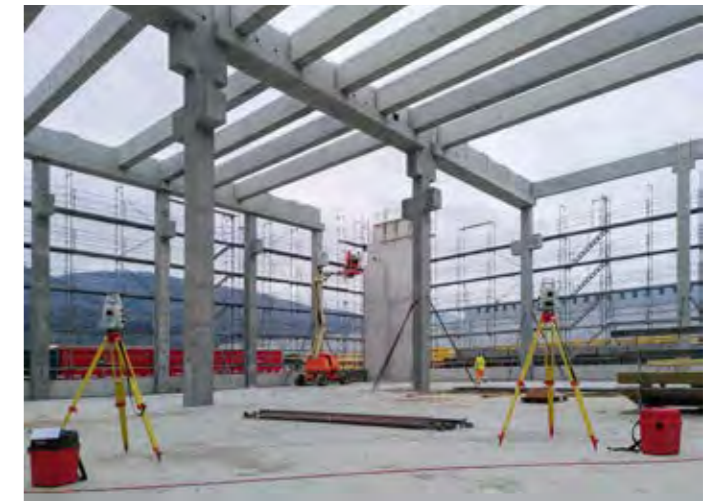
Unabhängige Kontrolle mit zwei Tachymetern
