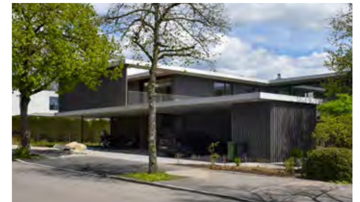
Klare Lesbarkeit und Präsenz durch horizontale Sichtbetondecken
