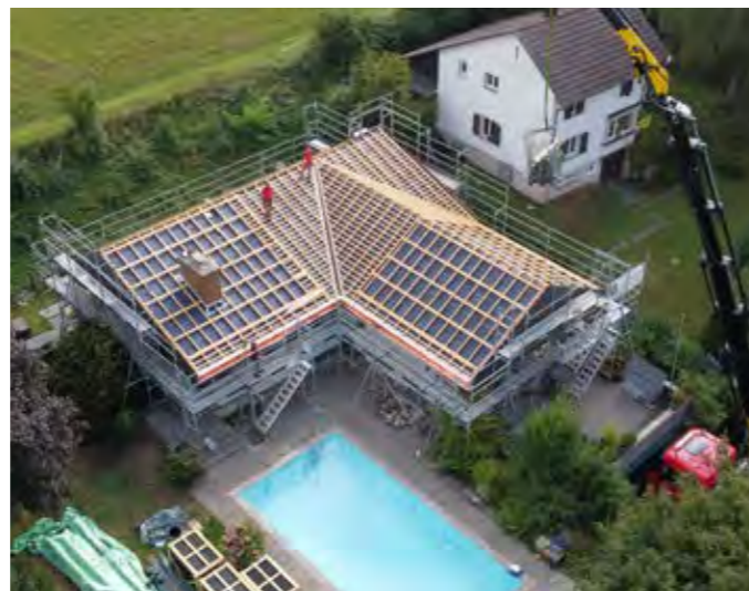
Energetische Sanierung der Gebäudehülle
