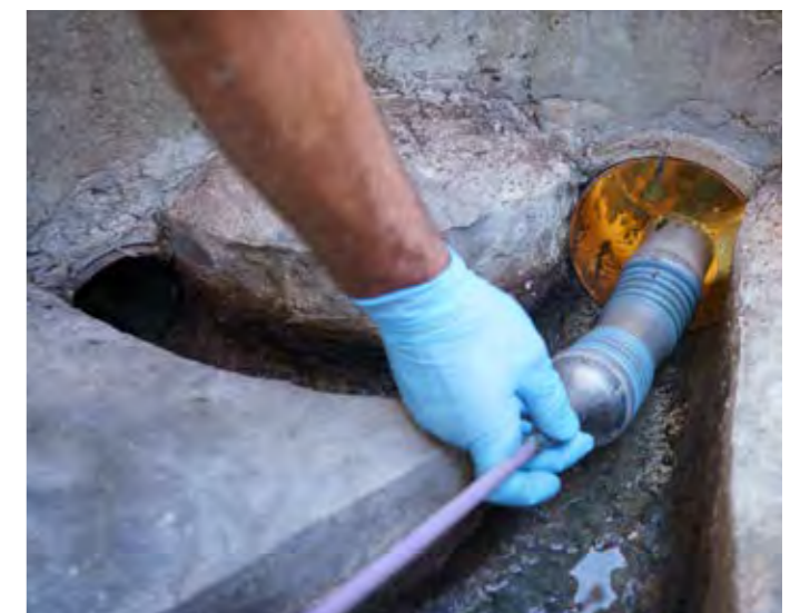
Positionierung der abbiegefähigen Kamera zur Leitungsinspektion
