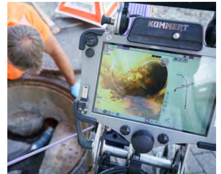
Inspektionskamera mit Livebild und Verlaufsanzeige
