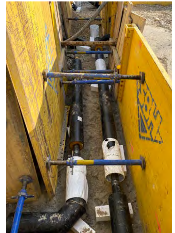
Neuerlegte Fernwärmerohre
