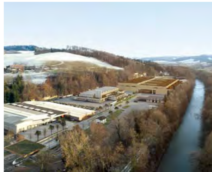
Gebäude Fels, Gebäude Emme und Mittelteil
