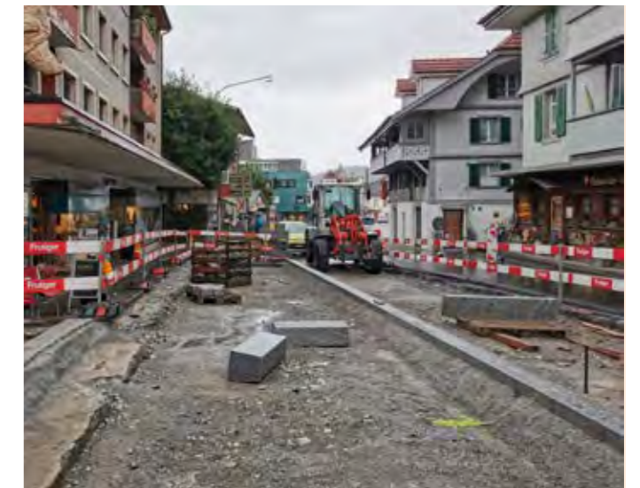
Verbauen der neuen Randabschlüsse für grosszügige Vorbereiche unter laufendem Gewerbebetrieb
