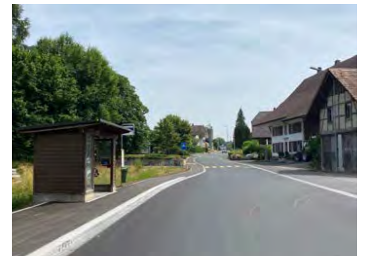
Die neu sanierte Solothurnstrasse mit hindernisfreier Bushaltestelle «Leuzigen, Schulhaus»
