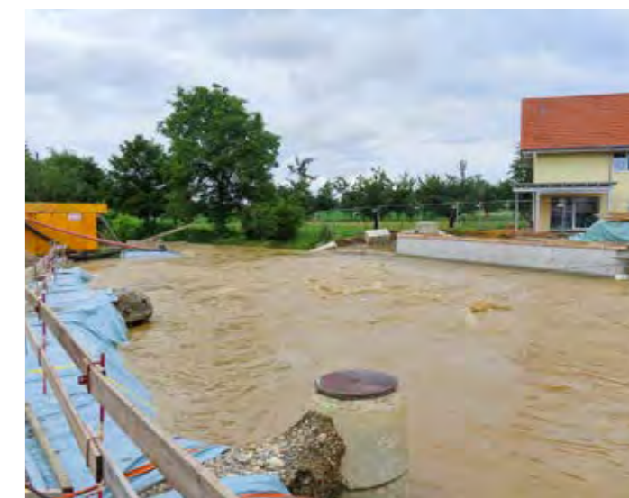
Überflutete Baugrube
